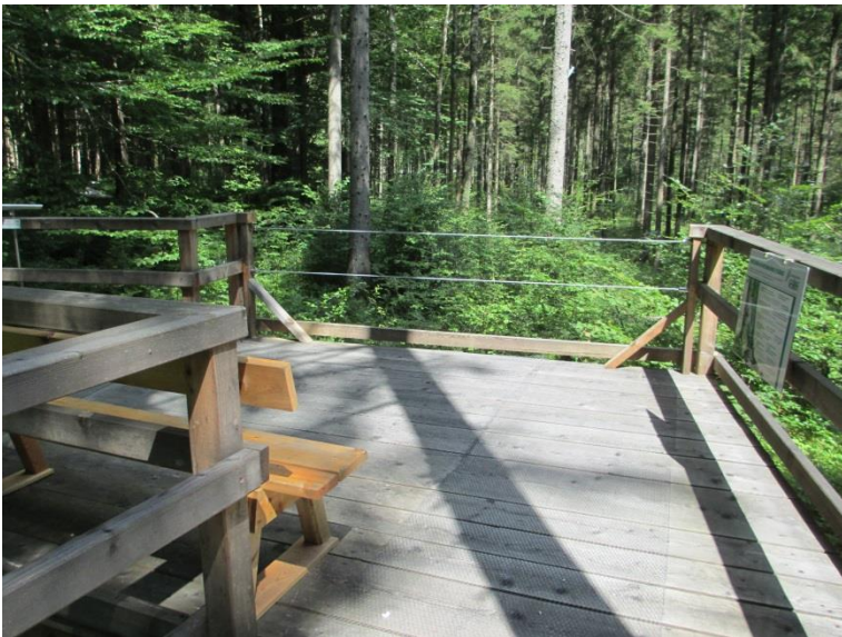
Abbildung 22: Drahtseile statt Balken schränken den Blick auf die Natur weniger ein. Quelle: Eigene Fotografie.
