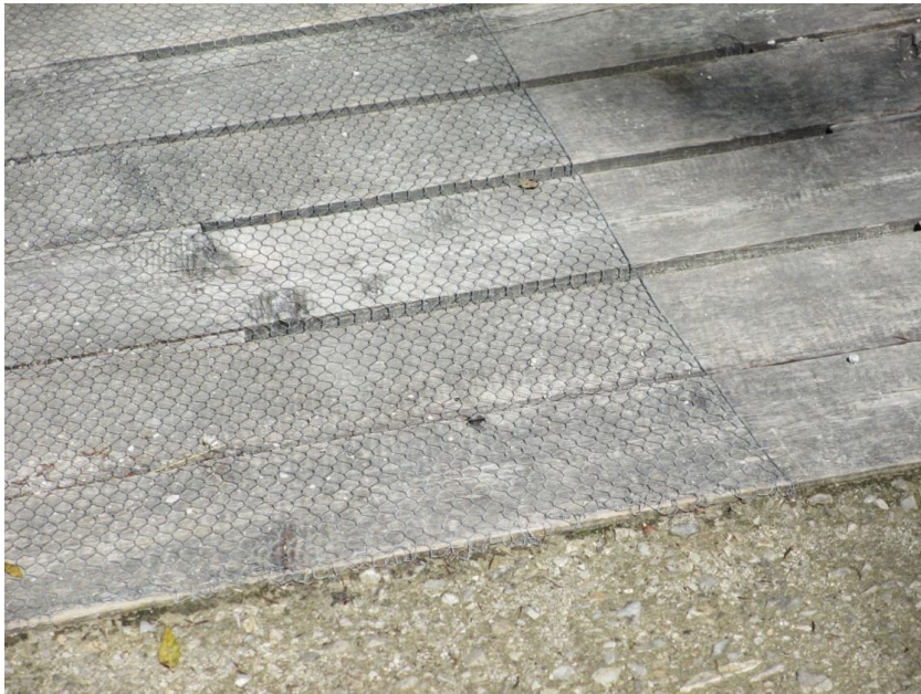
Abbildung 18: Der Holzsteg im Nationalpark Gesäuse wurde mit einem rutschfesten Gitter überzogen Quelle: Eigene Fotografie
